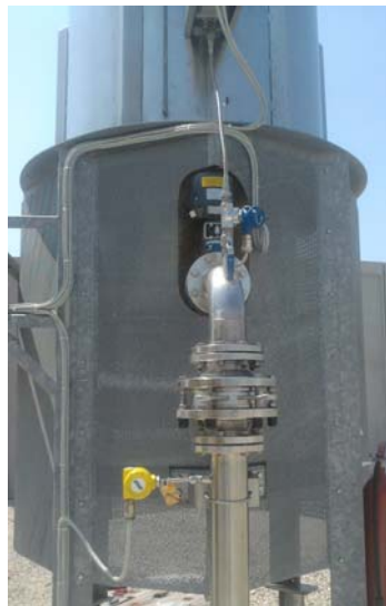
Arrestatore di fiamma, valvola gas e misuratore di portata Flame arrester ,gas valve and flow measuring
