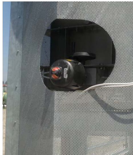
Attuatore elettrico per presa aria di combustione Electric actuated louver for combustion air intake
