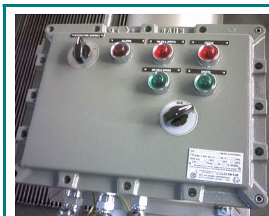
Pannello di controllo (Atex EExd) Control panel (Atex EExd)
